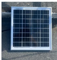
Figura 5.9 – Montarea panoului fotovoltaic pe o suprafață acoperită cu bitum/smoală
