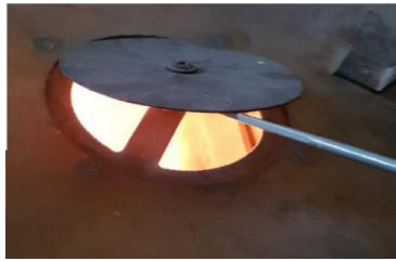
Fig.6.7 Aspectul flăcării în interiorul cazanului pe combustibil ulei uzat purificat
