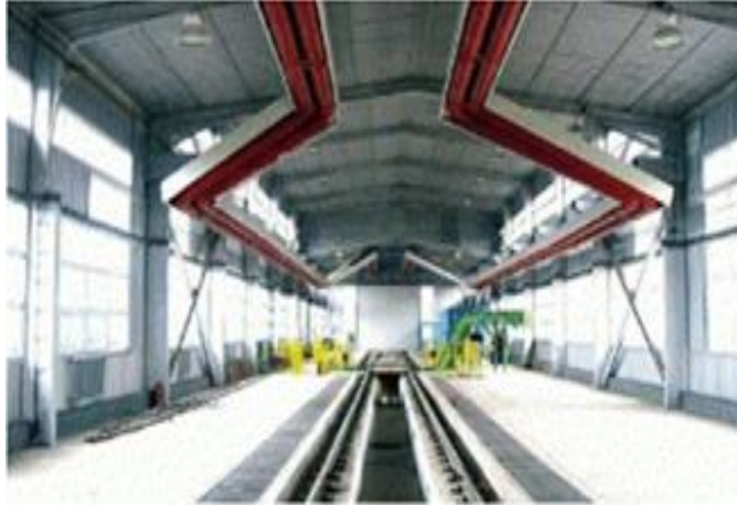
Fig.6.2 Tubulatura radiant OHA pe gaz
