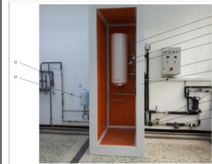
Fig.1. Imagine de ansamblu a standului experimental pentru testarea bio-izolațiilor în echipamente industriale
