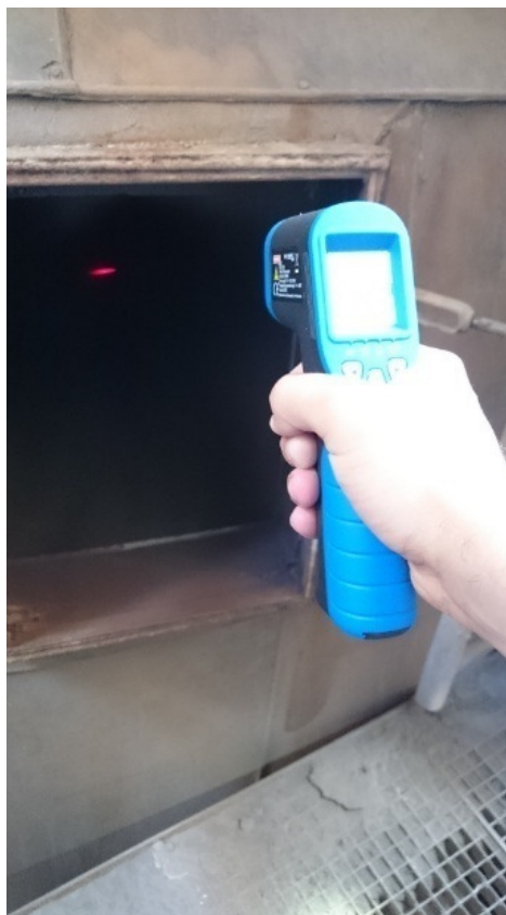
Fig. 5.10- Modul de efectuare al măsurărilor de temperatură la preîncălzitorul de aer analizat
